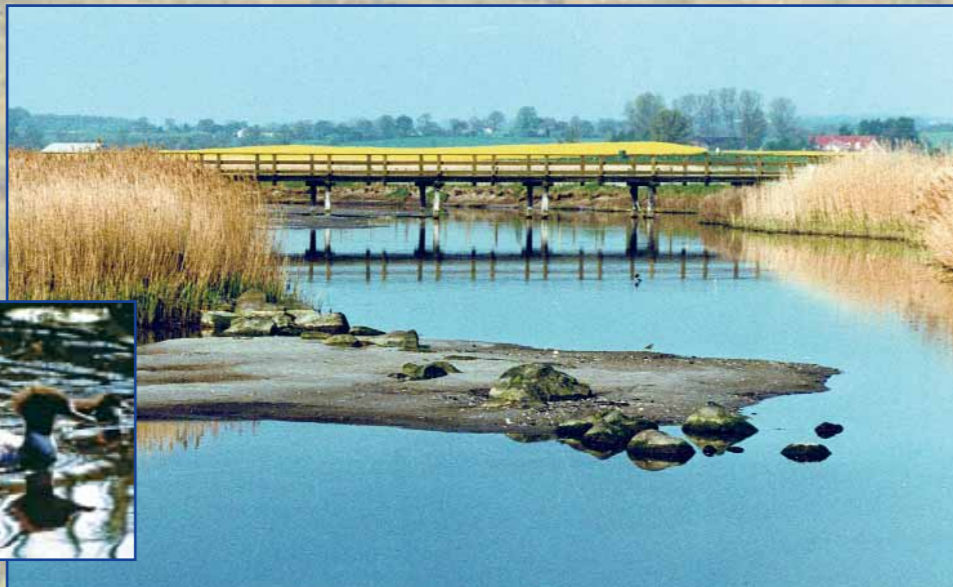
Brücke über den Broeck
